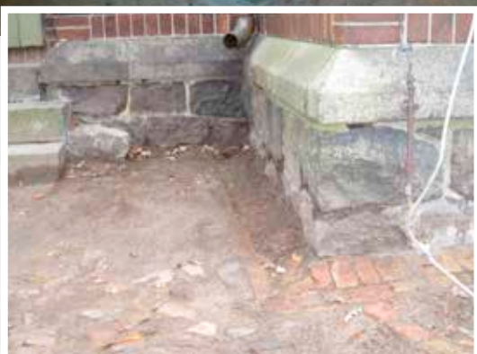
Im letzten November wurde bei Erdarbeiten die historische Regenentwässerung an der Südseite der Kirche wiederentdeckt. Sie war unter 20 bis 30 cm Boden verborgen und konnte wieder freigelegt werden.
